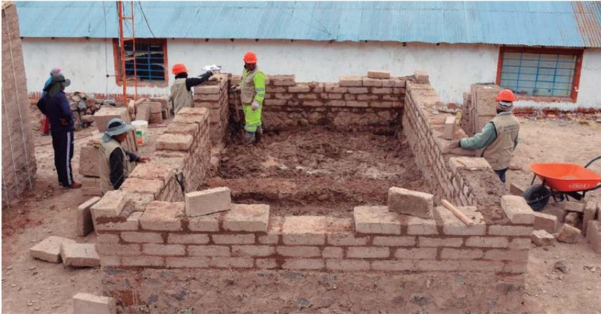
nes de totora, además de una capa de barro con mucha fibra para agregar más aislamiento. Asimismo se sellaron todos los orificios por donde se puede filtrar el aire frío.
