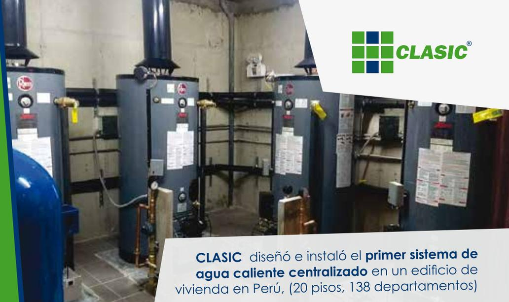
**CLASIC** diseñó e instaló el **primer sistema de agua caliente centralizado** en un edificio de vivienda en Perú, (20 pisos, 138 departamentos)
